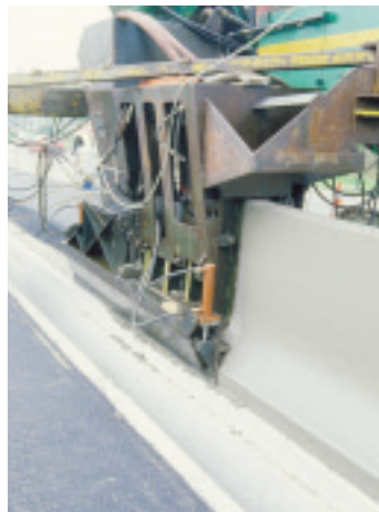
La machine à coffrage glissant peut, en régime normal, atteindre des cadences de 500 mètres linéaire par jour.
