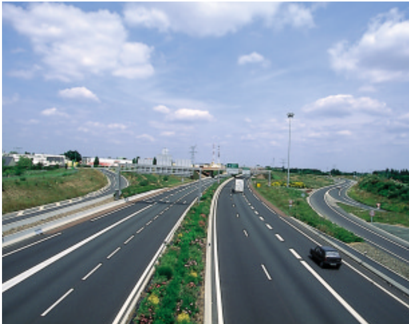
Double glissière végétalisée en site périurbain...
