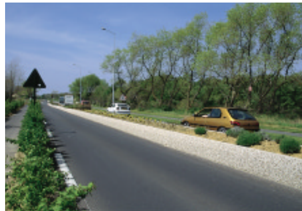
Dispositif de sécurité dans une zone périurbaine.
