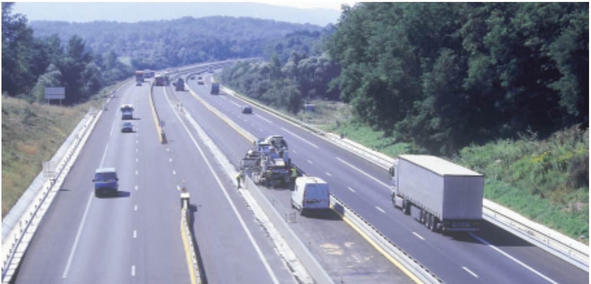
Autoroute A40 : réalisation de glissières de sécurité en béton armé, pérennes et faciles à entretenir.
