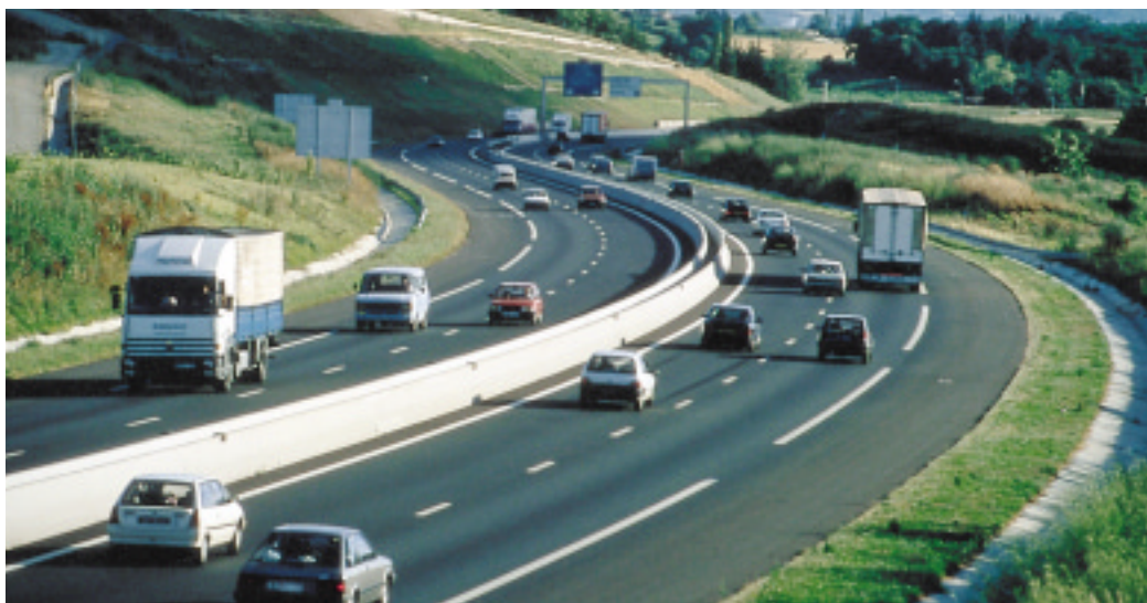
Insensibles aux eaux de ruissellement, les glissières béton ne polluent pas.
