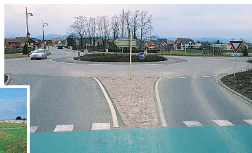
Renforcer la sécurité, c'est opter pour un matériau clair (meilleure visibilité) et indéformable (maintien de l'uni dans le temps).
