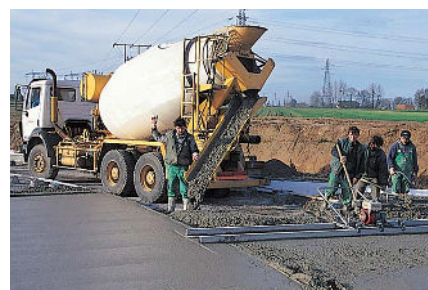
Le béton prêt à l'emploi est particulièrement adapté (en quantité et en qualité) à la réalisation des carrefours giratoires.
