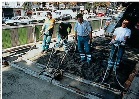
Bétonnage à la règle vibrante.
