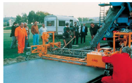
Bétonnage au vibro-finiisseur.
