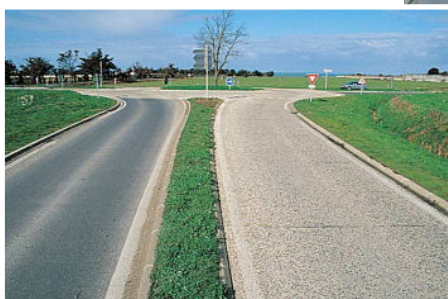
Renforcer la sécurité, c'est opter pour un matériau clair (meilleure visibilité) et indéformable (maintien de l'uni dans le temps).
