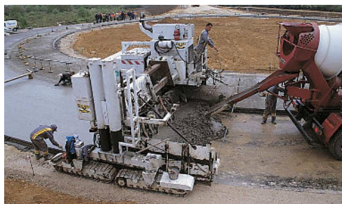
Bétonnage à la machine à coffrage glissant.
