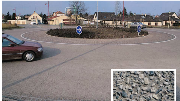
Le béton désactivé, ainsi qu'un choix adéquat des gravillons (couleur, dureté, etc.), sont la solution idéale pour les carrefours giratoires urbains.
