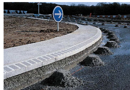
Bordures de l’îlot central posées avant le bétonnage de l’anneau.
