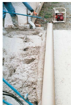
Bétonnage au striker.
