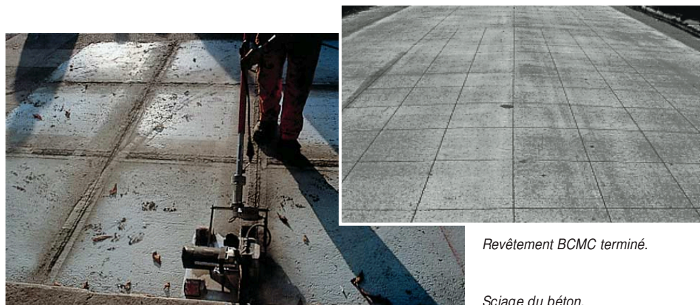
Sciage du béton.
