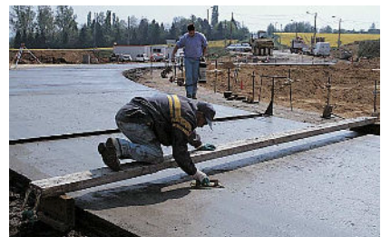
Une passerelle est toujours nécessaire pour les finitions des surfaces.
