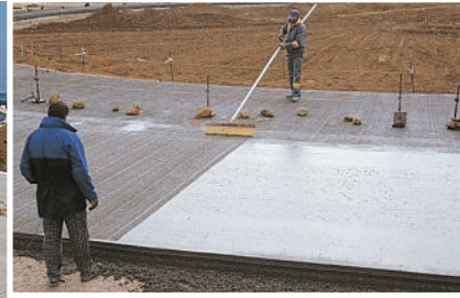
Giratoire de gron (Yonne) : structure en béton à joints goujonnés sur fondation en béton maigre.
