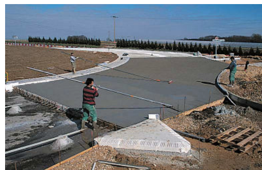
Bétonnage de l'anneau du giratoire et du dispositif de raccordement à la bretelle.
