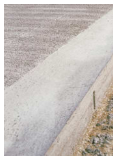
La plasticité du béton autorise la réalisation de systèmes d'assainissement intégrés au revêtement.
