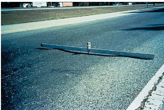
Des chaussées soumises à un trafic intense et canalisé ou des aires de stationnement finissent toujours par s'orniérer.
