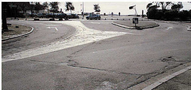
Dégradations structurelles observées sur les carrefours giratoires : faïençage et orniérage des couches bitumineuses.
