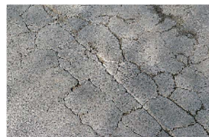
Dégradations structurelles observées sur les carrefours giratoires : faïençage et orniérage des couches bitumineuses.
