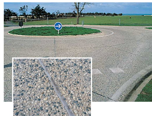
Giratoire des Campani (RD 735) : structure béton à joints non goujonnés sur fondation en g rave ciment.
