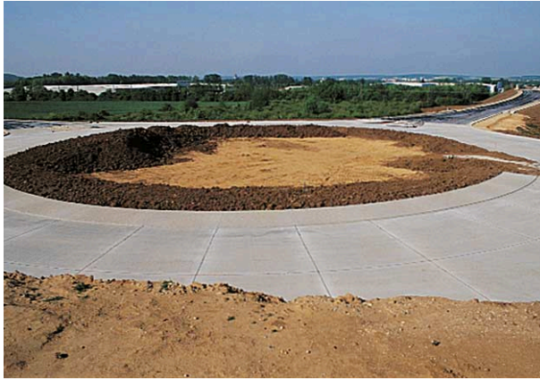
Giratoire de gron (Yonne) : structure en béton à joints goujonnés sur fondation en béton maigre.
