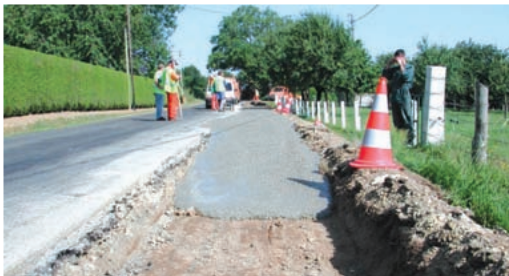
Mise en œuvre du matériau auto-compactant Maces 140.
