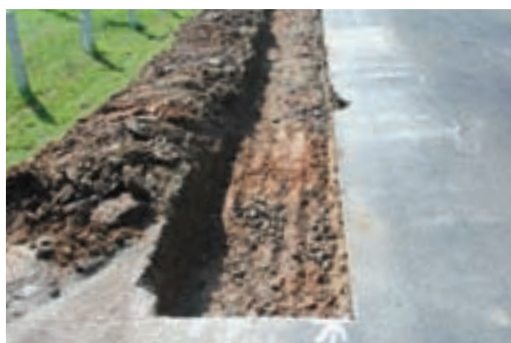
Planche d'essai effectuée sous le contrôle du laboratoire DDE de LAVAL.
