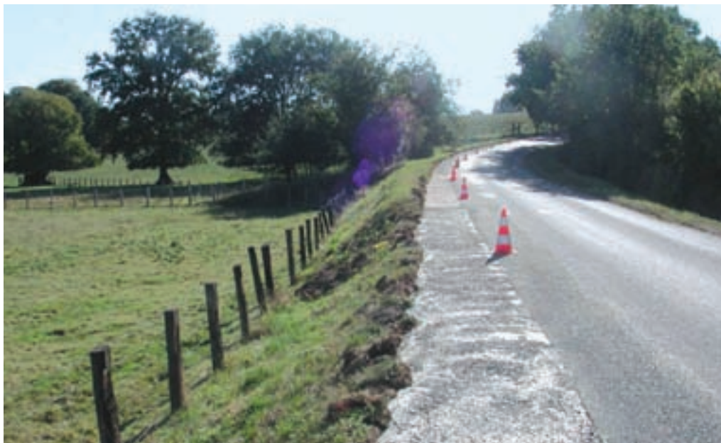
État de la chaussée élargie avant la réalisation de la couche d'enrobé.
